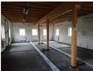
Das Bild täuscht. Die Arbeiten sind schon weit fortgeschritten.
